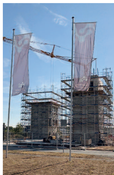
Der aktuelle Baufortschritt am Kreativforum.
