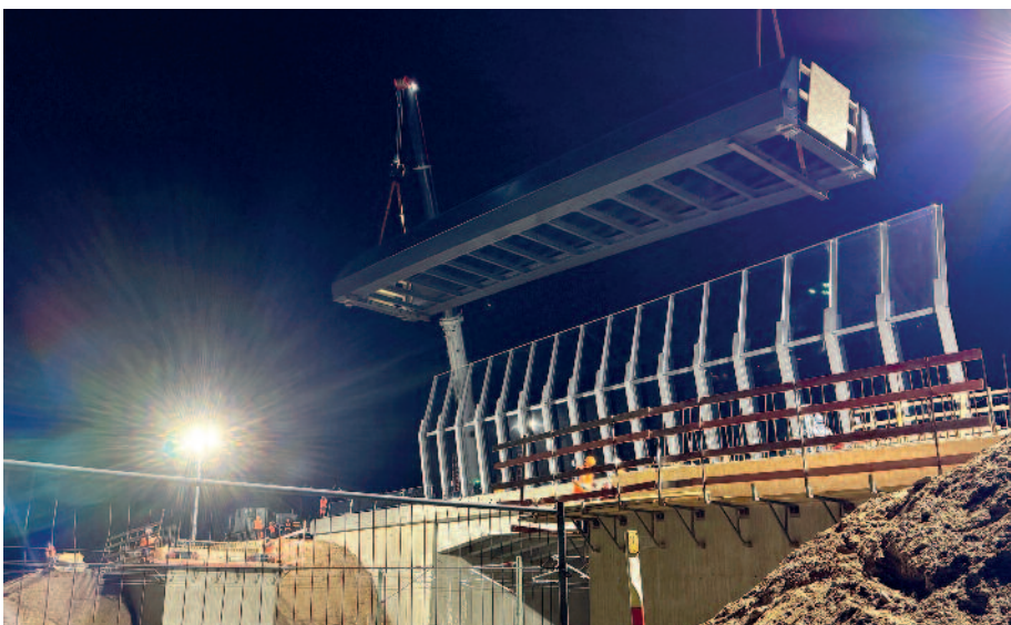
Der Stahlüberbau für die neue Geh- und Radwegbrücke wurde an seinen Platz gehoben.
