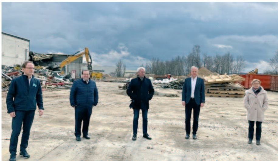
Die Abrissarbeiten liegen gut im Zeitplan, darum kann nach derzeitigem Stand der Bau des Innovationszentrums noch in diesem Jahr starten.
