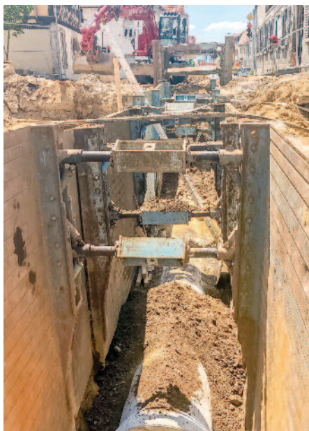
In der Lichtenfelser Straße und am Marktplatz konnten die Arbeiten nicht ohne Aufgrabung erfolgen, da die Schäden zu groß waren.
