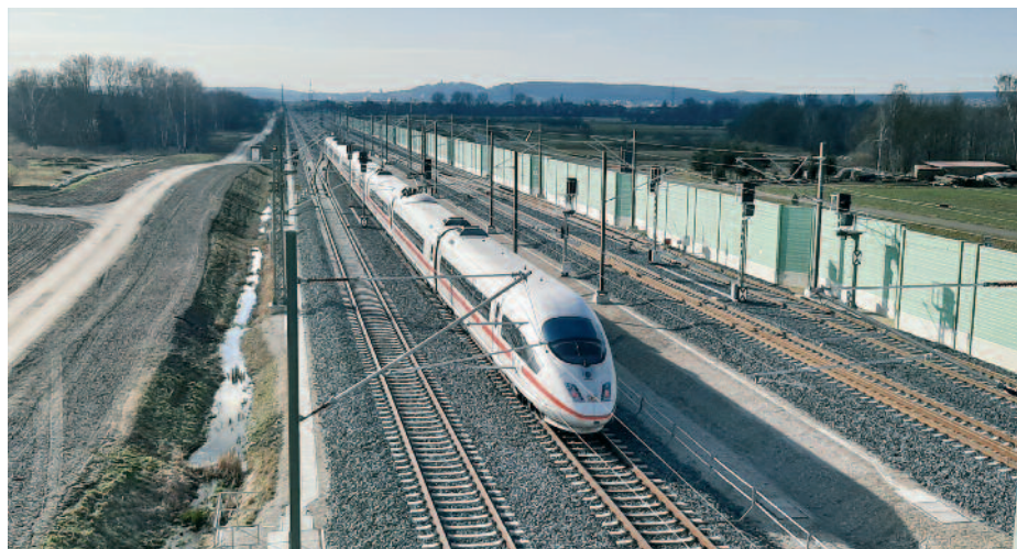
Der Ausbau der ICE-Strecke schreitet gut voran.
